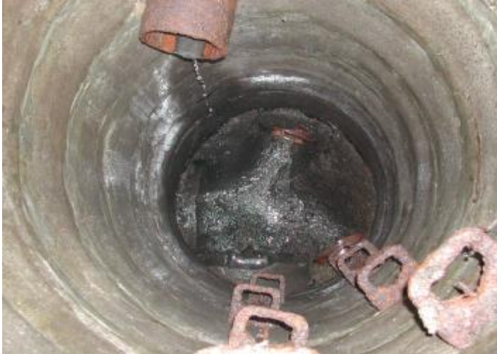
Obrázek č. 4 – kanalizační šachta – nízký průtok
