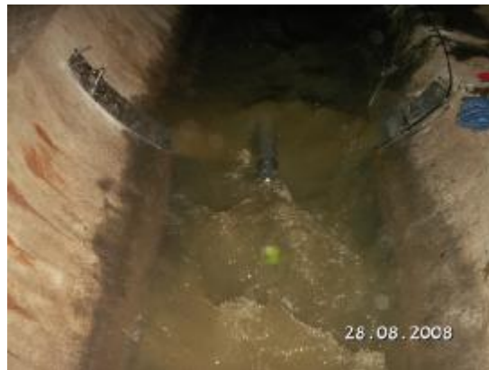
Obrázek č. 2 instalace zařízení ve stoce
