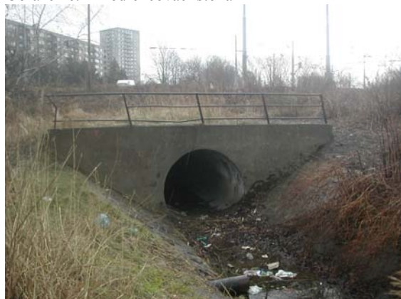
Obrázek č. 1 – odlehčovací stoka
