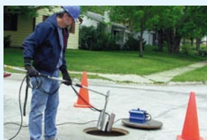
Montáž pod úroveň vozovky
