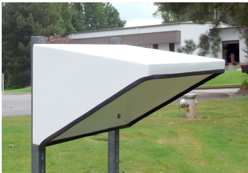
Obraz 3-15 Stříška ochraňující jednotku proti okolním vlivům
