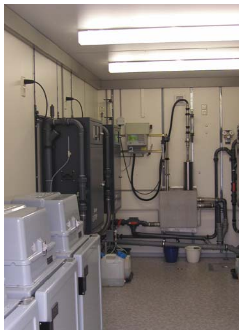
Obrázek 4 On-line analyzátory a vzorkovače v monitorovací stanici
