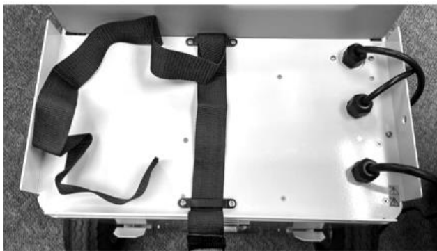
Nainstalovaný popruh bateriového boxu
